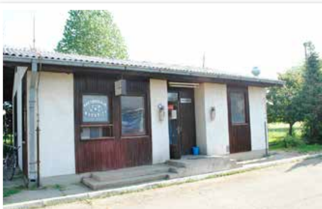
Poste de garde
